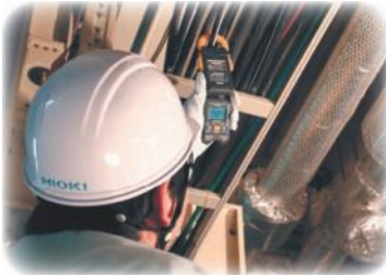
Jednostavno merenje na žicama na plafonima
